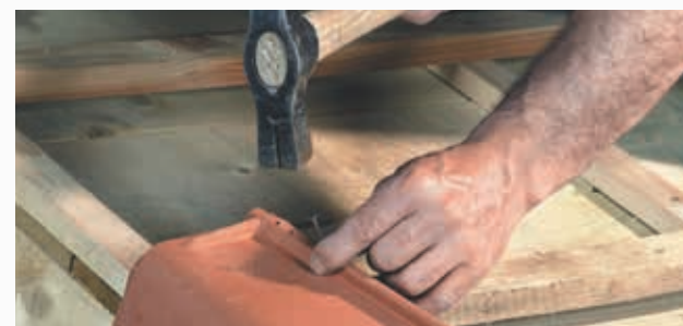
Fixation des rives rondes individuelles à emboîtement en rive latérale gauche et droite par vis et rondelle d'étanchéité.
