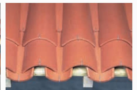
Réalisation d'un 1 er rang d'égout à «rang décalé». Ce principe de mise en œuvre n'exclut pas la fixation des tuiles de courant et de couvert en rives et en égout suivant les cas précités. Cette mise en œuvre peut s'effectuer sur support continu ou sur liteaux.
