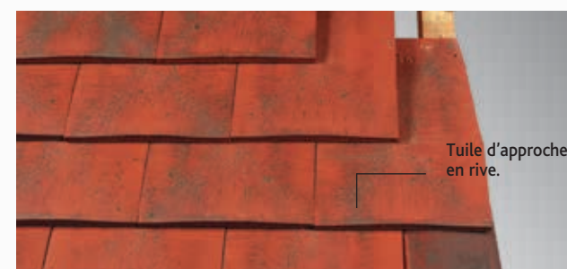
Mise en œuvre des tuiles d'approche en rive, posées un rang sur deux. Ces tuiles sont à découper suivant dimensions définies sur coupe transversale.
