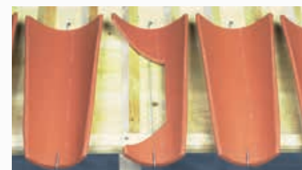
Fixation des tuiles de courant du 1er rang d'égout, par crochets longs à œil Réf. CRCAN.550
